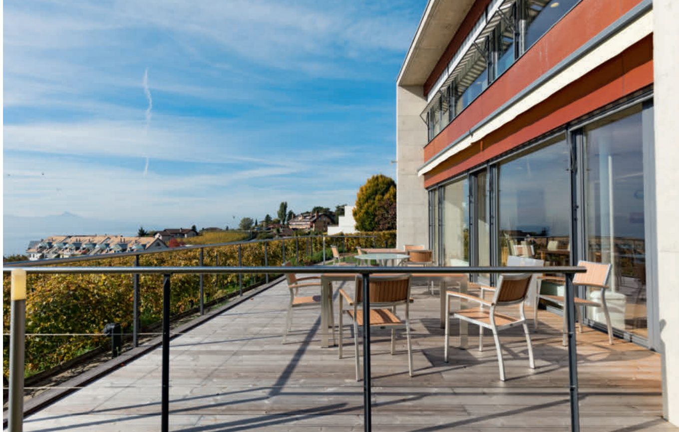
Balkon des Hôpital du Lavaux: Hier wird im Rahmen eines Pilotprojekts eine von zwei Palliativstationen geführt. Sie stellt quasi ein Bindeglied zwischen Akutversorgung und Alters- und Pflegeheim dar.
