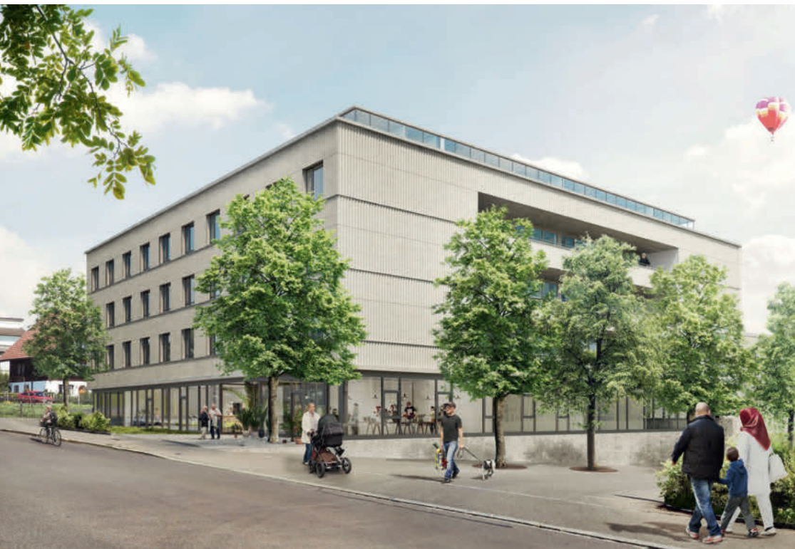
Kleinwohnungen für Senioren (Bild links) in Bazenheid SG. Die beiden Häuser stehen unmittelbar (Bild rechts). Der Spatenstich für die gesamte Anlage erfolgte Anfang Mai. Visualisierung: nightnurse images gmbh
