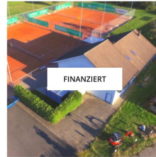
SOLARANLAGE Solarpanel auf Tennisclub in Hochdorf 752 CHF inkl. MwSt.
