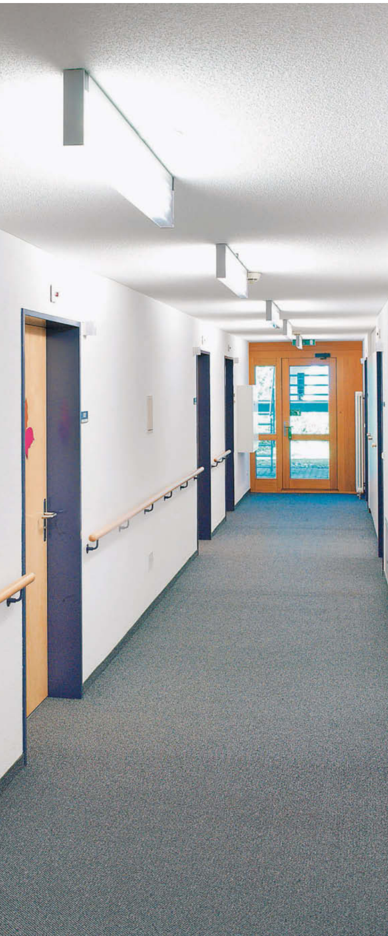
Beleuchtung im Gang eines Pflegeheims: Den Bedürfnissen der Bewohner angepasst.
